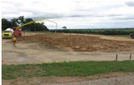
Pouring the piers
